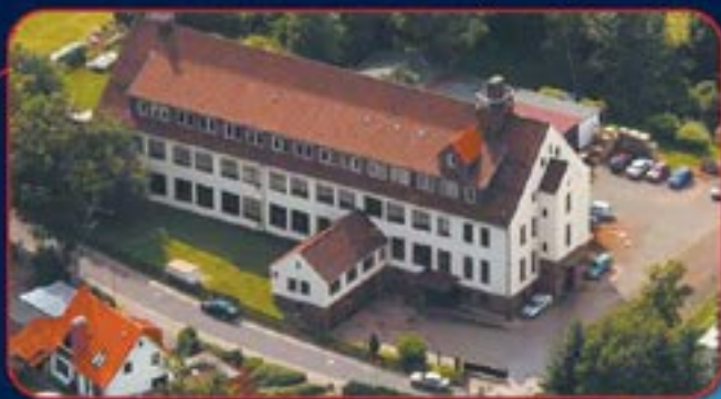
Zakład 1 – Triftstraße 1a – Zakład budowy maszyn i urządzeń
